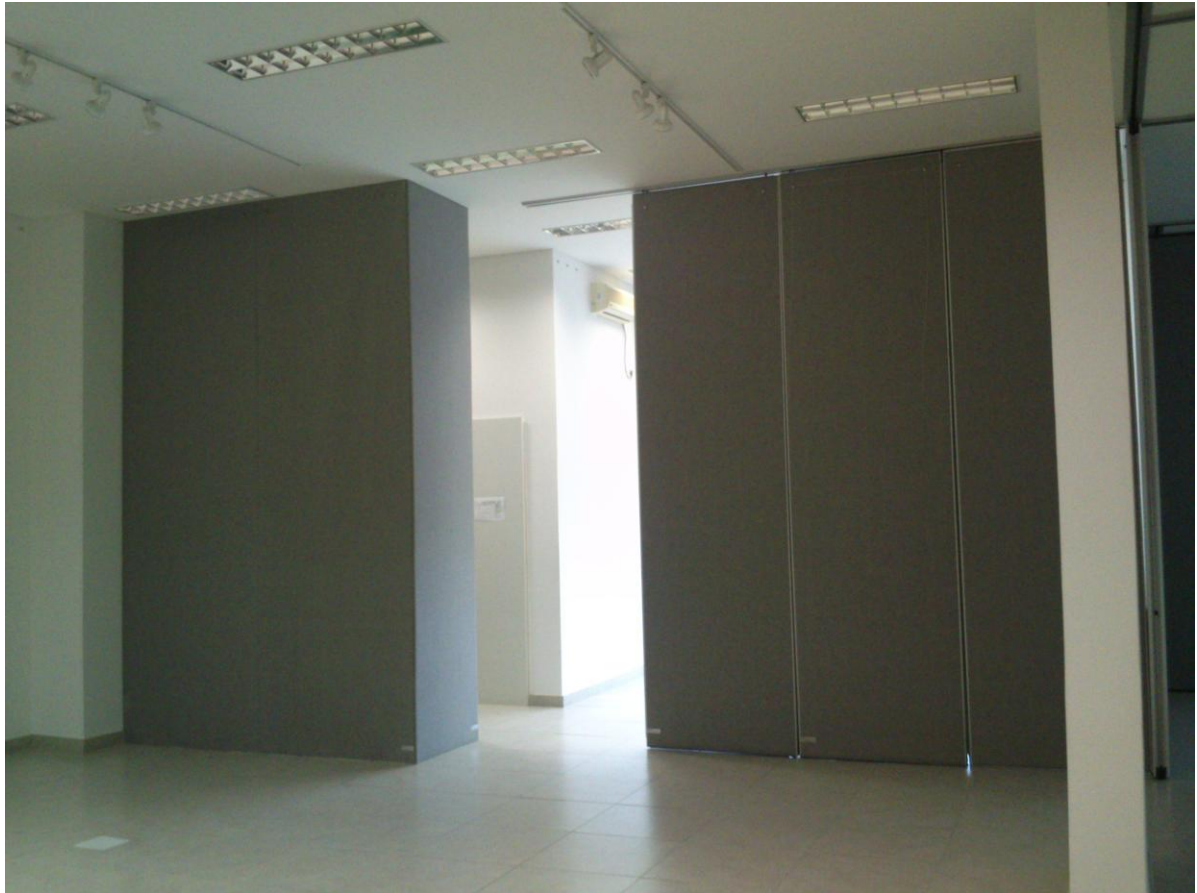
FOTO 06 – PAINÉIS MÓVEIS E FIXOS
